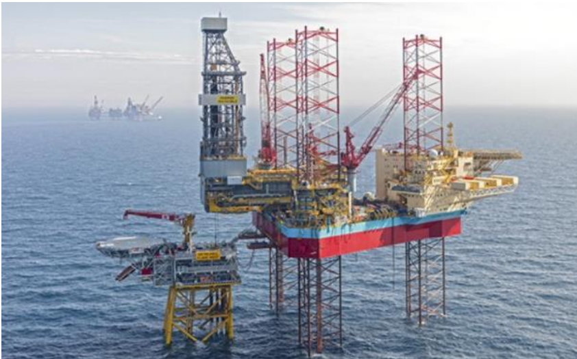
Figur 2: Maersk Invincible i drift over en fast brønnhodeplattform på Valhall Flanke Vest
