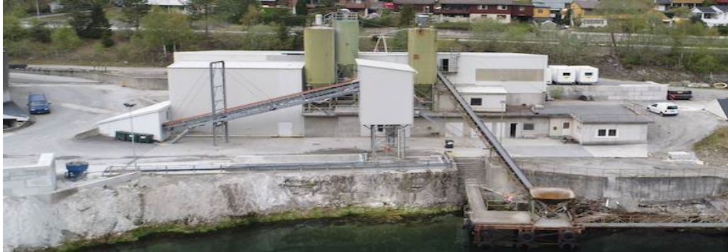
Figur 2 Eksempel på stasjonært betongverk, Odda Betong 70
