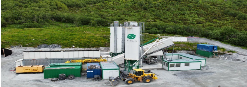
Figur 3 Eksempel på mobilt betongverk, Ølen Betong (Geiranger) 76
