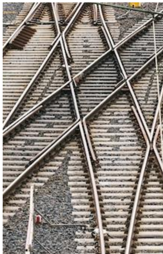
Eksempel på sporvekselsviller brukt i kryss
