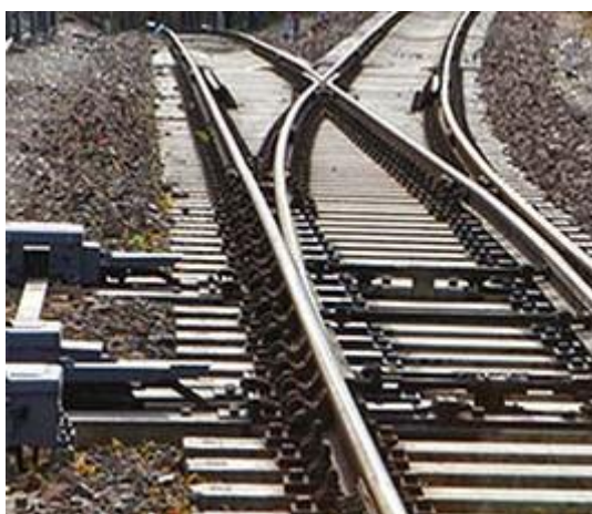
Eksempel på sporvekselsviller brukt i vekselssystem
